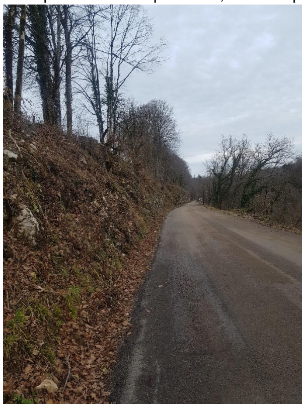
La D 229 après sécurisation des abords
