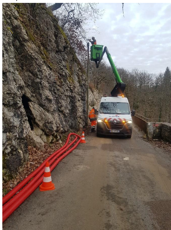
Remise en place de la fibre
